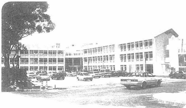
本館研修棟全景
